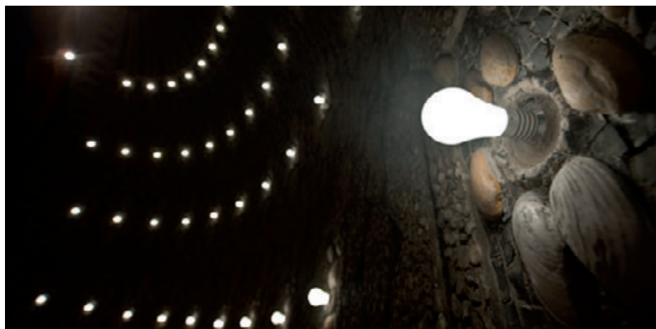
Bild 3 Die in Glühlampenform gestalteten Acrylglas-körper mit den eingebauten warmweissen, dimmbaren LED.
